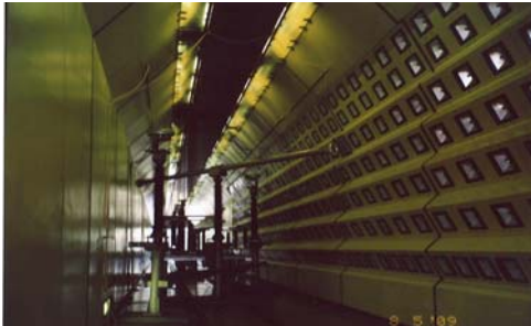
Klima-Wind-Kanal von innen (Spur 1,435)
